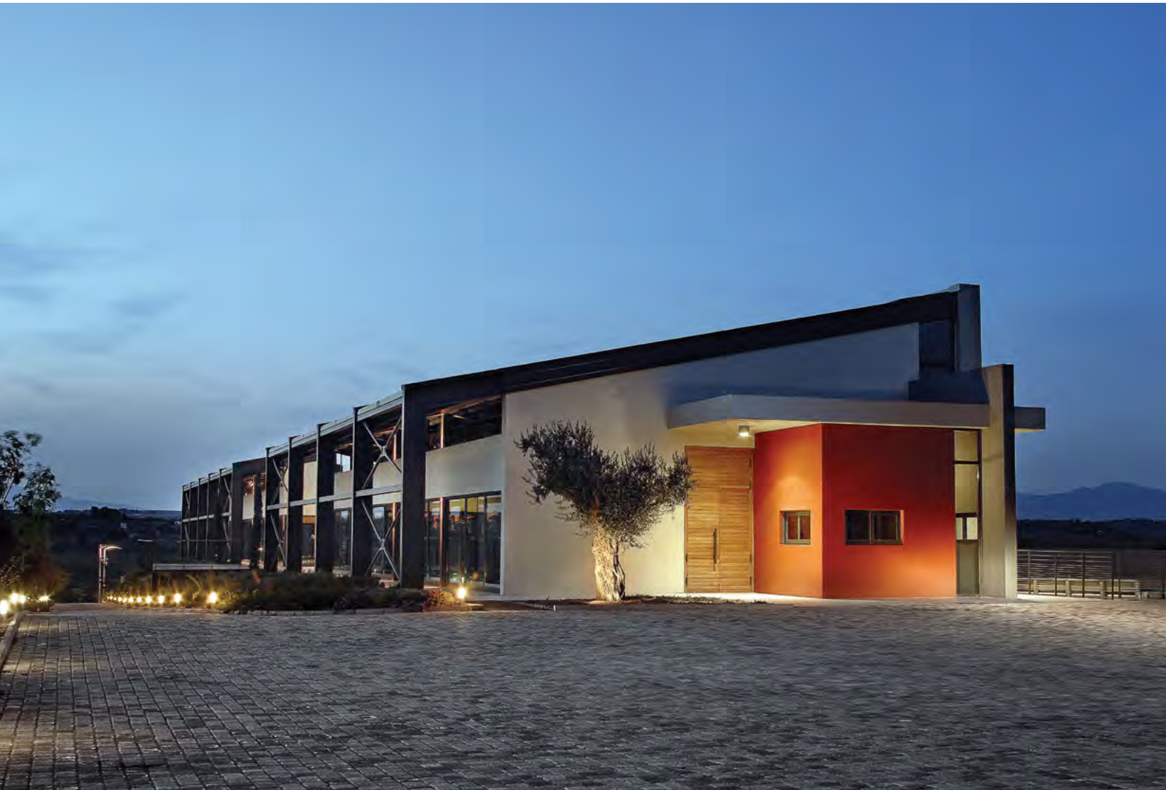
Το εντυπωσιακό βιοκλιματικό κτίριο του οινοποιείου Παπαγιαννάκου.
