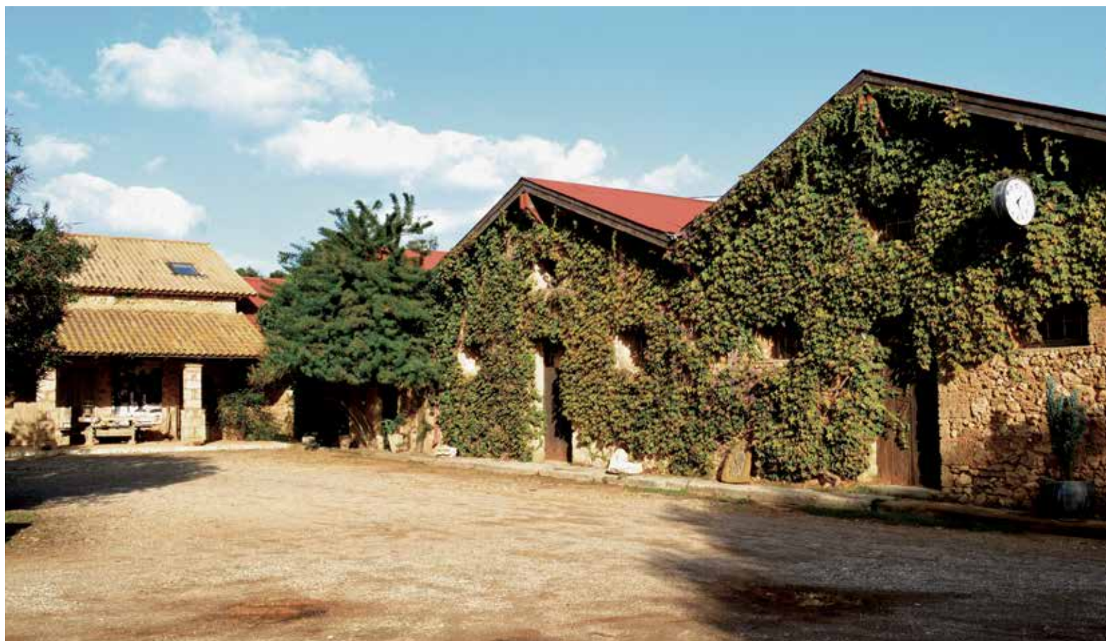
Το πρώτο σπίτι, χτισμένο το 1874, το οποίο σήμερα φιλοξενεί τα γραφεία και τον χώρο γευσιγνωσίας.
